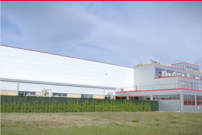
Centro de I+D+I de Bombas de Calor Saunier Duval en Vitoria.
